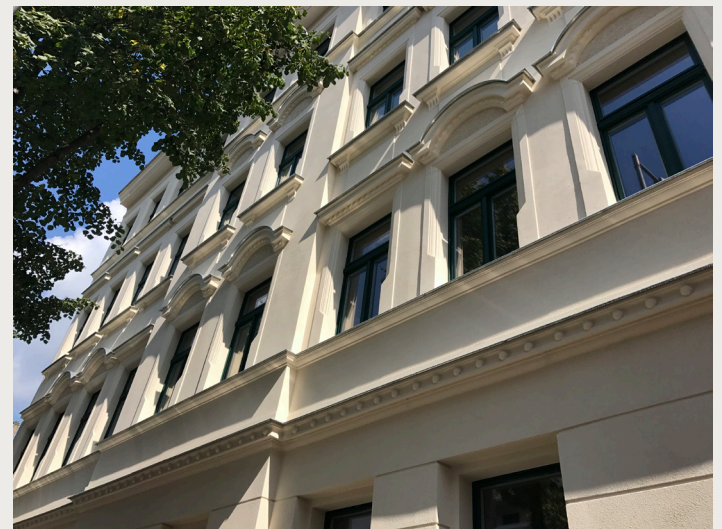
Referenz: Zuckelhäuser Straße 7 & 9, Leipzig
